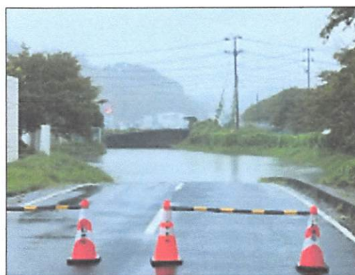
冠水で閉鎖されたアンダーパス
